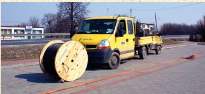
Trwają prace układania światłowodu.
